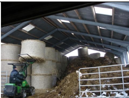
Foto 51: Halmhus og overdækket møgplads i en og samme bygning – sparer mange penge til "vandbeholder" og udkørsel af overfladevand
